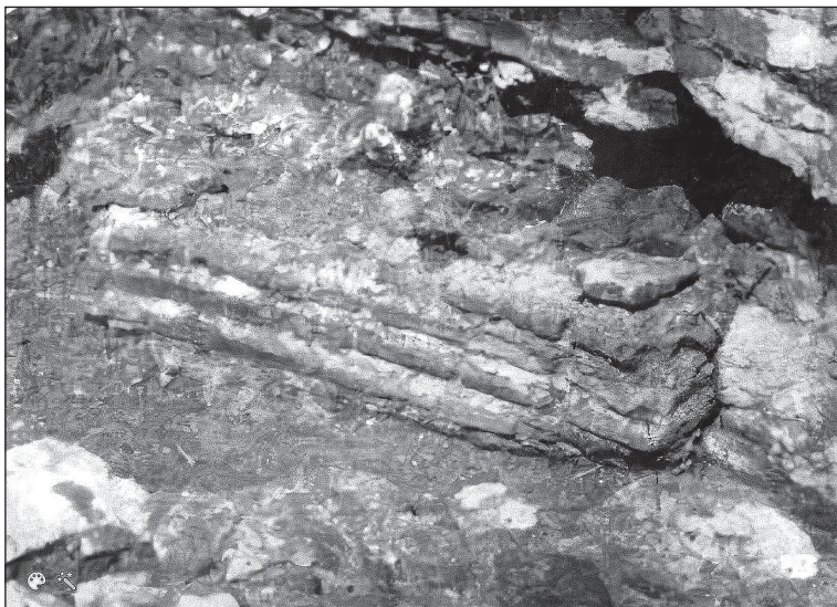
Рис. 4. Фрагмент оборонного муру XII ст. у місці примикання до Троїцької надбрамної церкви (за Богусевич 1951)
