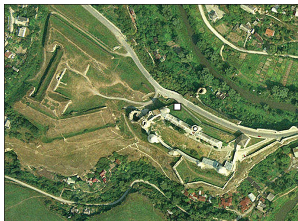
Рис. 1. Місце обвалу стіни
