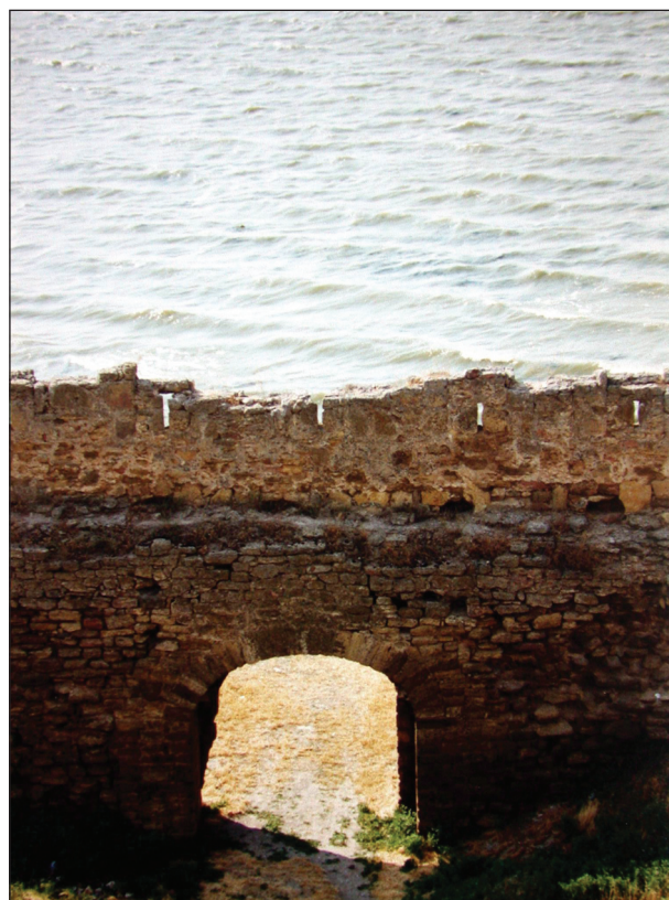
Рис. 2. Білгород-Дністровська фортеця, стіни нижнього двору Fig. 2. Bilhorod-Dniester fortress, walls of the lower courtyard
