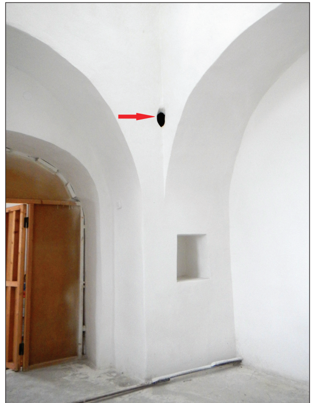
Рис. 9. Голосник в основі склепіння каплиці другого ярусу Успенського собору (фото 2020 р.)
